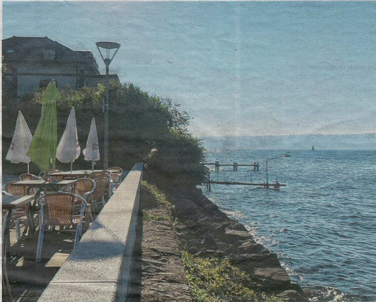
Il n'est pas encore possible de circuler entre Grande Rive et le port des Mouettes.
